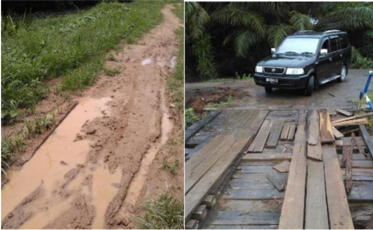
Gambar 27 Jalan Tanah Sungai Rambut – Berbak (kiri) dan Jembatan Kayu di Kecamatan Berbak (kanan)
