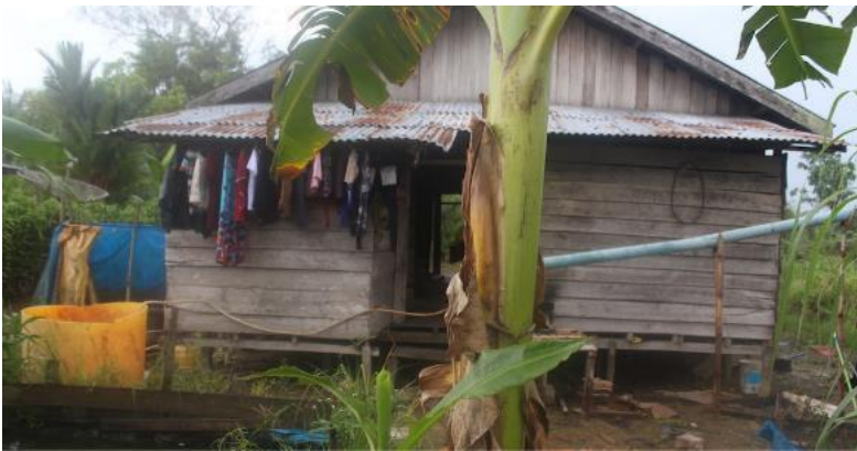
Gambar 46 Salah Satu Cara Penampungan Air Hujan Menggunakan Talang Air
