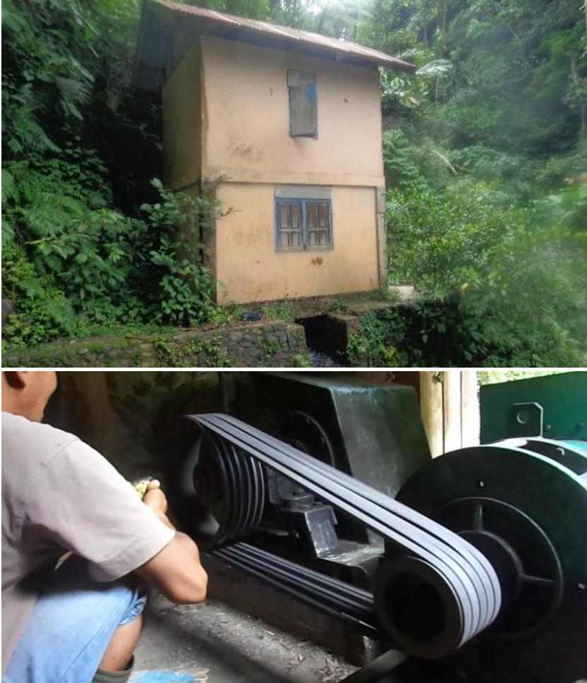
Gambar 10 Atas, bangunan PLTMH (Pembangkit Listrik Tenaga Mikro Hidro) dan Bawah, Generator PLTMH
