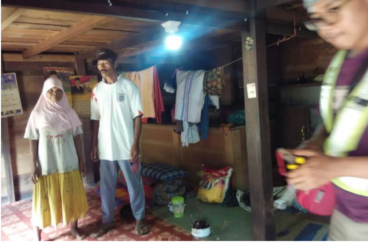
Gambar 87 Rumah Bapak Sabar yang Tuna Netra dan Istrinya Tuna Rungu, Sudah Terpasang Lampu PLTS Jorong Tandai Bukik Bulek.
