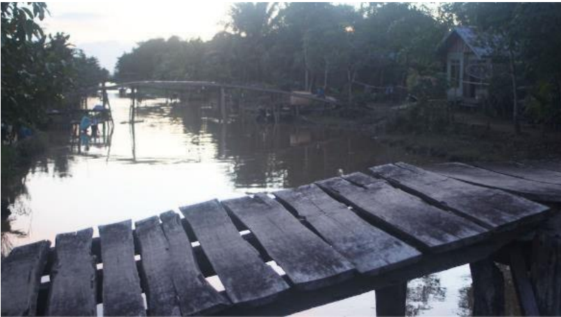
Gambar 44 Jembatan Penghubung Antara Jalan Sekunder dengan Perumahan Warga
