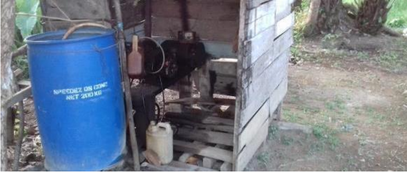
Gambar 45 Genset (mesin diesel) yang Dimanfaatkan Warga
