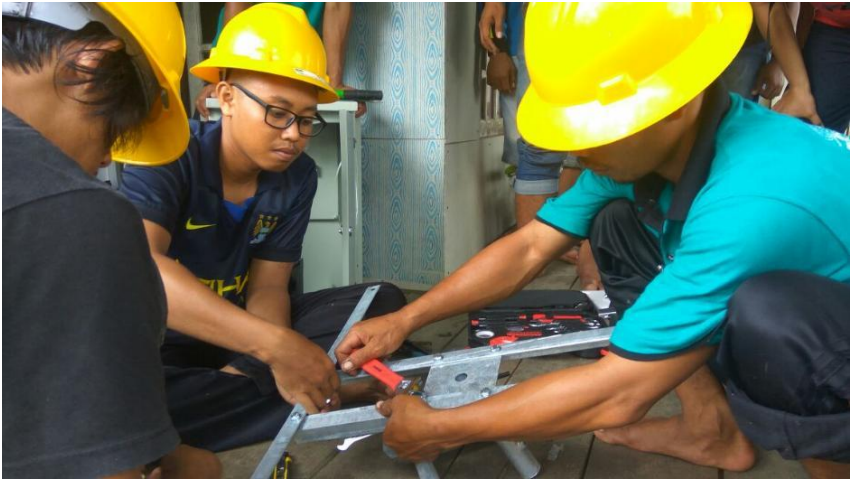
Gambar 88 Pelatihan Pemasangan PLTS Kepada Kader Hijau dan Relawan Warga di Desa Rawasari
