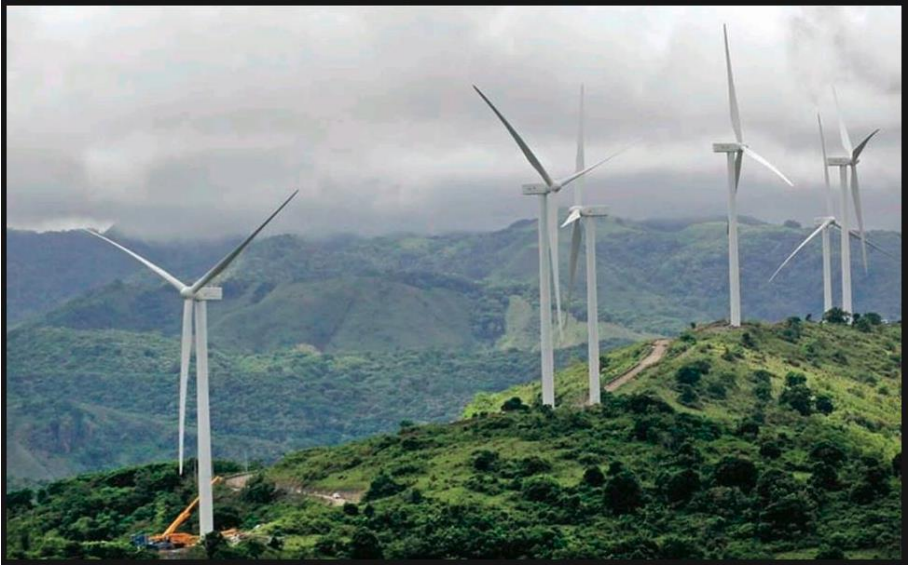
Gambar 10 Pembangkit Listrik Tenaga Angin 175
